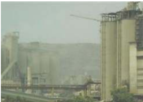
Contaminación por polvillo de cemento, estado Anzoátegui. Fuente:
