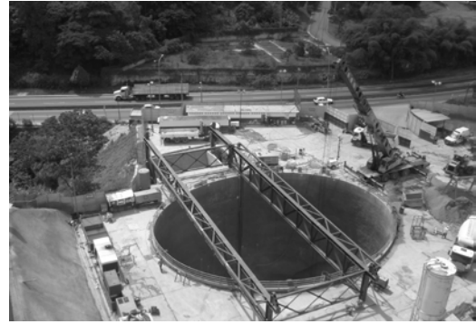
Fig. 3. Distribución de equipos en el Frente. Fase I: excavación y túnel minero.
