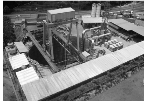
Fig. 8. Fase II del Frente de Obra, acciones de control de ruido tomadas.
